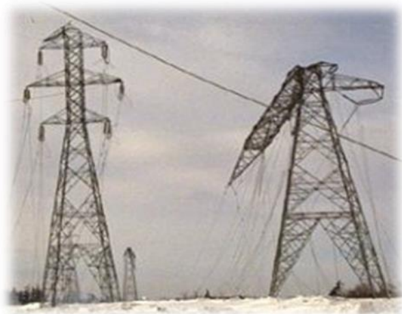
Расми 4. Дастгирии ҳавоии харобшуда интиқоли нерӯи барқ дар шароити яхбандӣ
