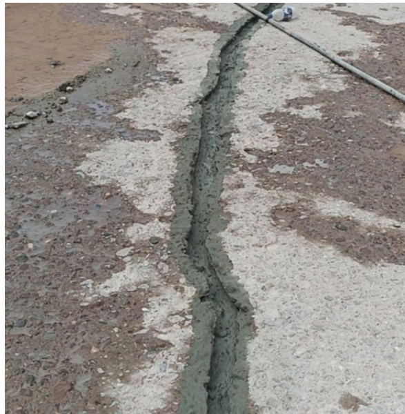
Расми 1. Раванди дарзбанд намудани тарқиши бетон бо маводи полиуретан.
