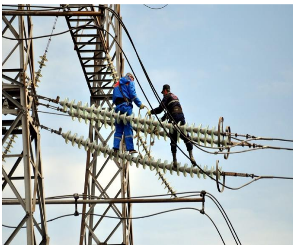
Расми 2. Бо камон вайрон кардани домани изолятор
