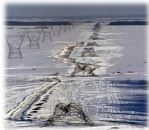
Расми 5. Каскади вайроншавии таъхҳои хатӣ дар натиҷаи яхбандӣ
