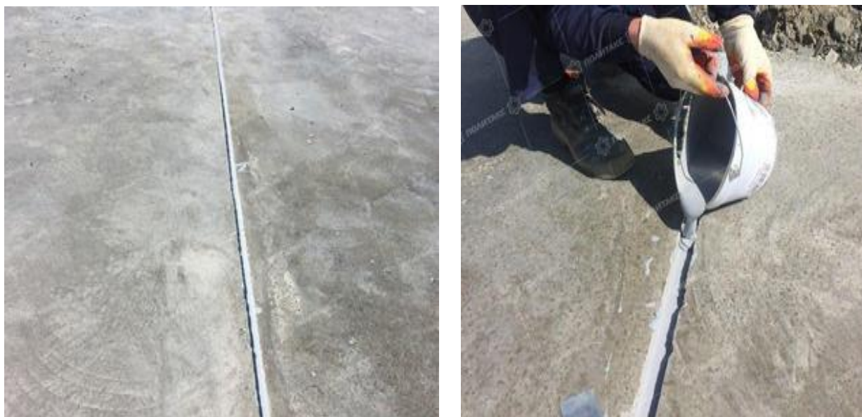
Расми 2. Рӯйпушо ва дарзбандиҳои полиуретанӣ барои пайвандҳои фаршҳои бетонӣ.
