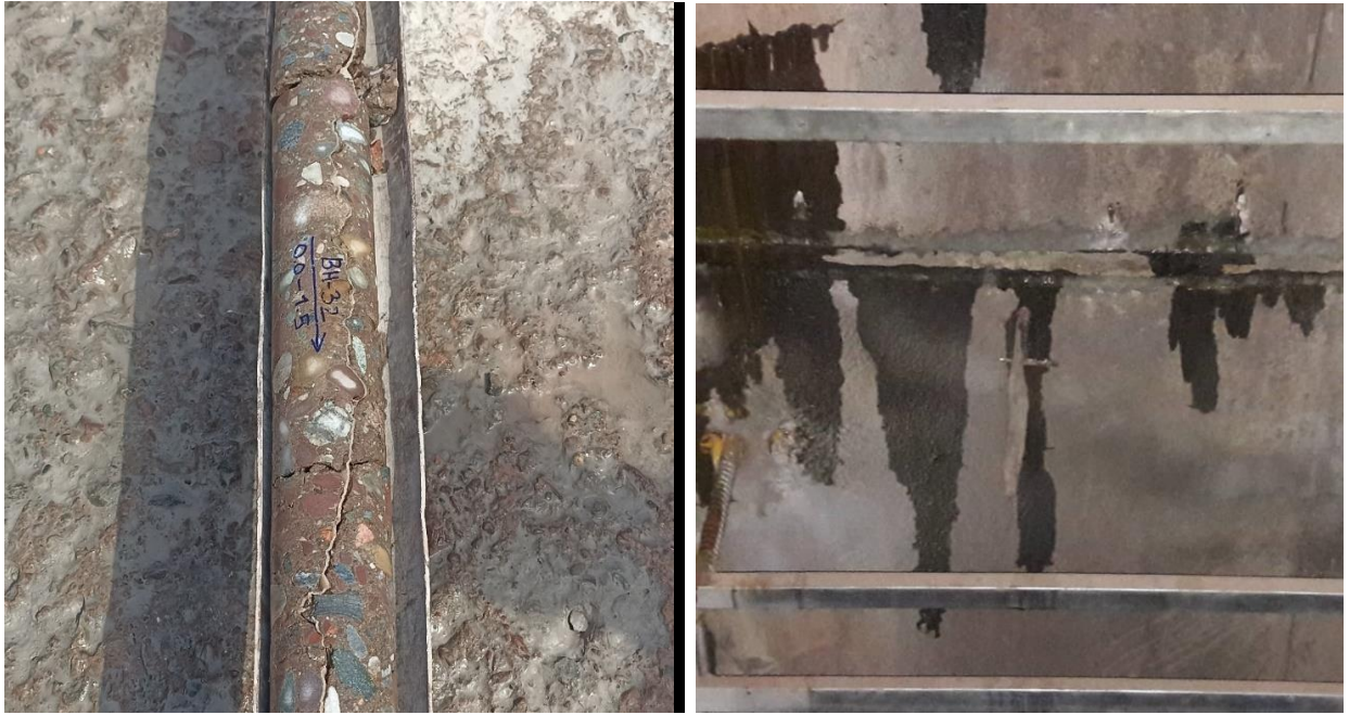
Расми 4. Намунаи таъмири дарзҳои сарди бетонҳои қабланхобонидашуда дар нақбҳои зери фишорқарордоштаи гидрогиреҳи энергетикӣ.
