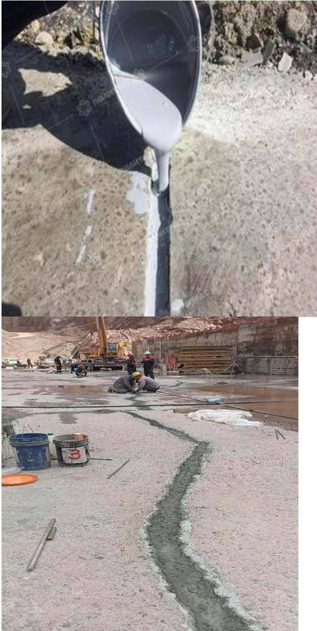
Расми 3. Намунаи истифодабарии маводи полиуретан дар иншооти гидротехникӣ.
